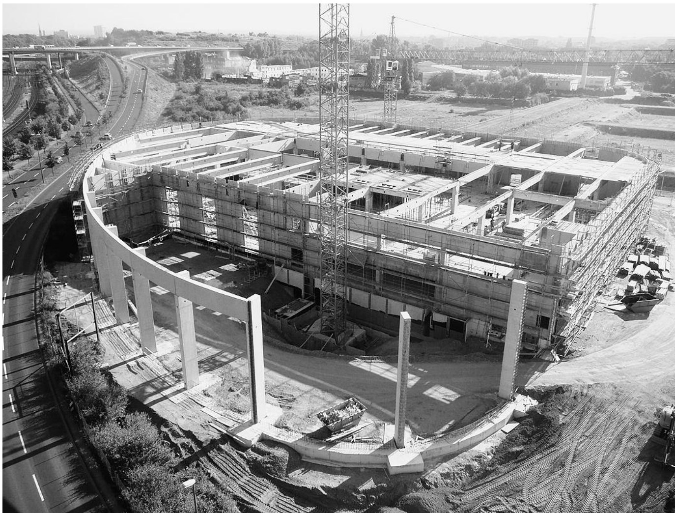
Fertigteil- und Teilfertigteilkonstruktionen mit hohen Spannweiten kennzeichnen den Bau des „Odysseum“. Das Aussteifungskonzept des ellipsenförmigen Baukörpers beruht auf Berechnungen der Tragwerksplaner IDK Kleinjohann. Foto: Kaspar Kraemer Architekten
