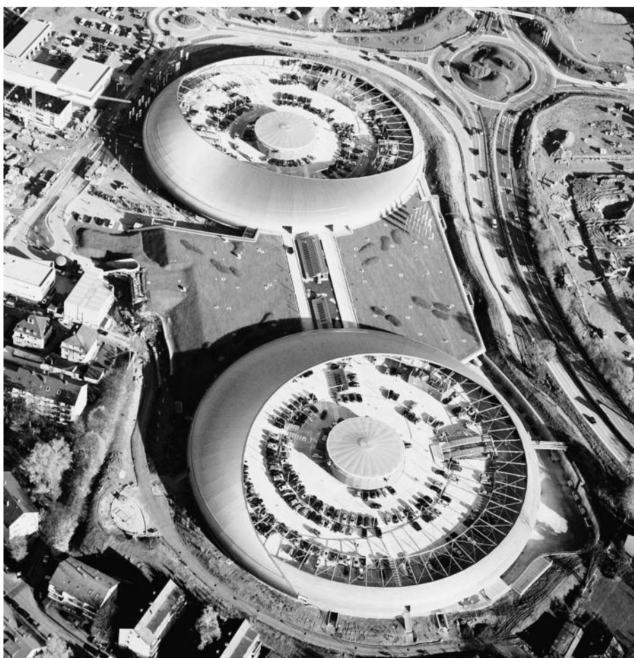
Fachmarktzentrum in Baden-Baden: Die runden Baukörper von je 10 000 m 2 wurden ohne zusätzlichen Schalungsaufwand mit Spannbetondecken ausgeführt; ebenso die 10 000 m 2 mit Dachbegrünung. Foto: Kastell
