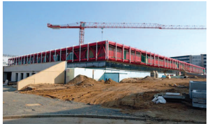
Bild 4. Nordwestansicht: Die Stahlfachwerkträger sind montiert und Rot lackiert. Das umgebende Gelände wird bis in Höhe des Glasbandes angeschüttet. (Fotos: 1,3 und 4 IDK Kleinjohann; 2 DLR)
