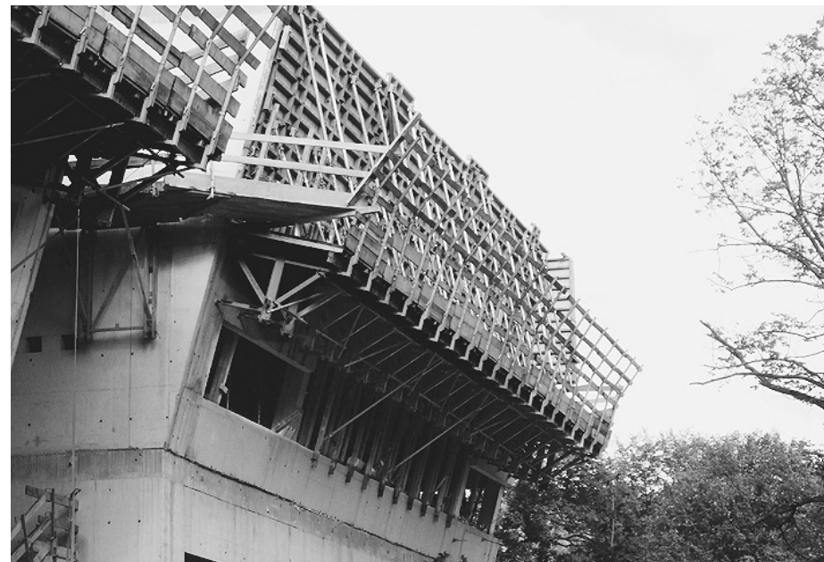
Deutlich sichtbar ist hier die ab dem Obergeschoss nach außen geneigte Längswand. Auf den geneigten KLK-230-Klettergerüsten steht die ebenfalls geneigte Wandschalung.
