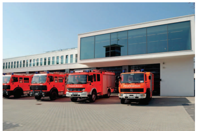
Bild 2 Der zweigeschossige, nicht unterkellerte Neubau aus Stahlbeton misst ca. 45,00 m in der Länge und ca. 13,50 m in der Breite (auskragend bis ca. 15,50 m)
